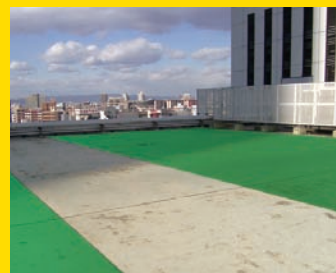
屋上防水シート
