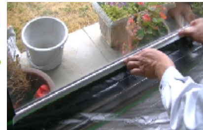
シーリング部保護養生
