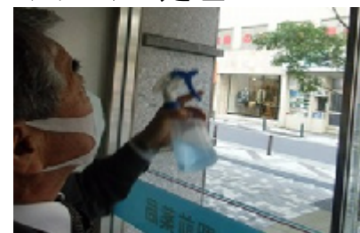
プライマー処理
