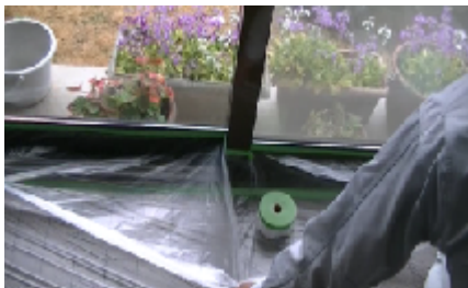
床面・壁面の保護養生
